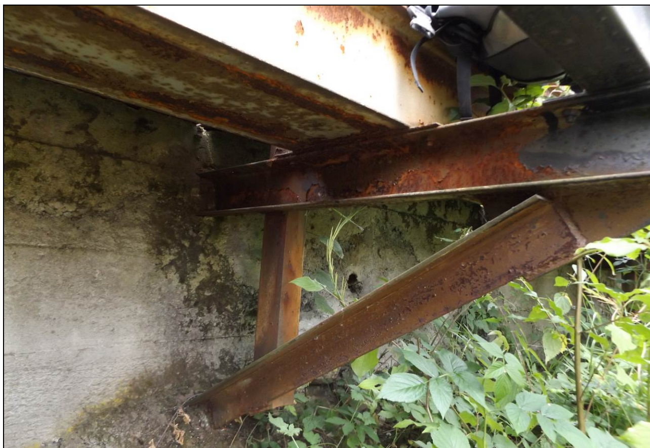
Obr. č. 5 – pohled na tížnou opěrnou zeď a silně zkorodovanou, ocelovou konstrukci
