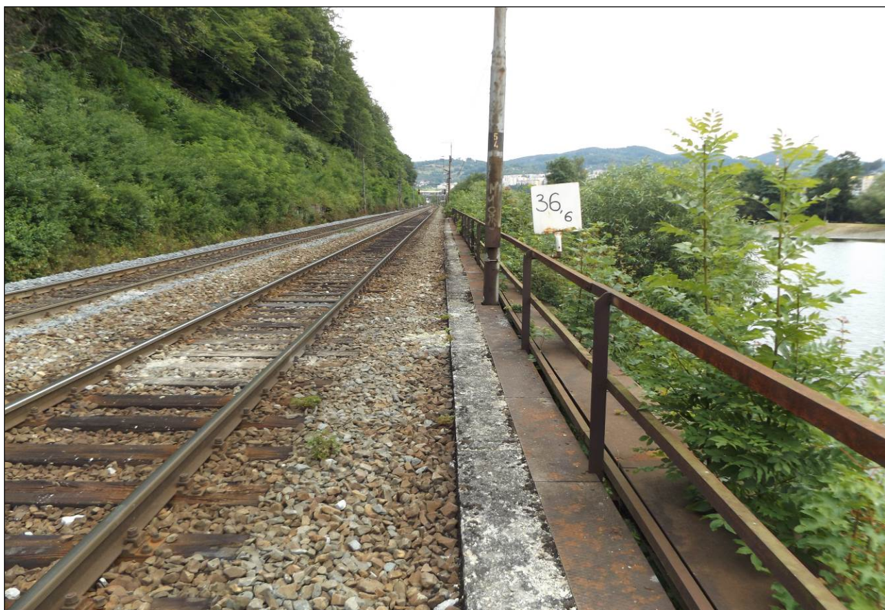
Obr. č. 7 - betonová římso opěrné zdi degradovaná vegetací
