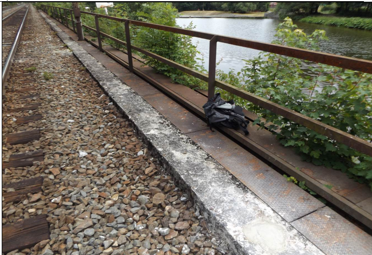
Obr. č. 6 – betonová římso opěrné zdi
