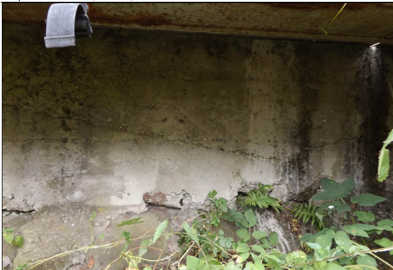
Obr. č. 8 – spodní část opěrné zdi s viditelnými průsaky vody spojené s tvorbou usazenin vyloužených z pojiva
